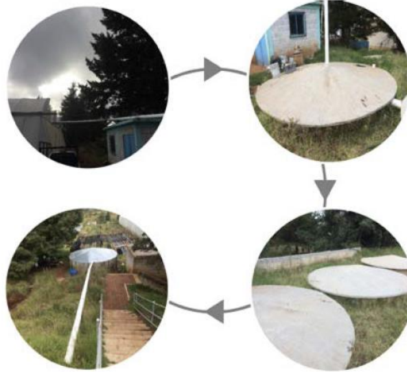
Figura 2. Sistema de captación de agua de lluvia
